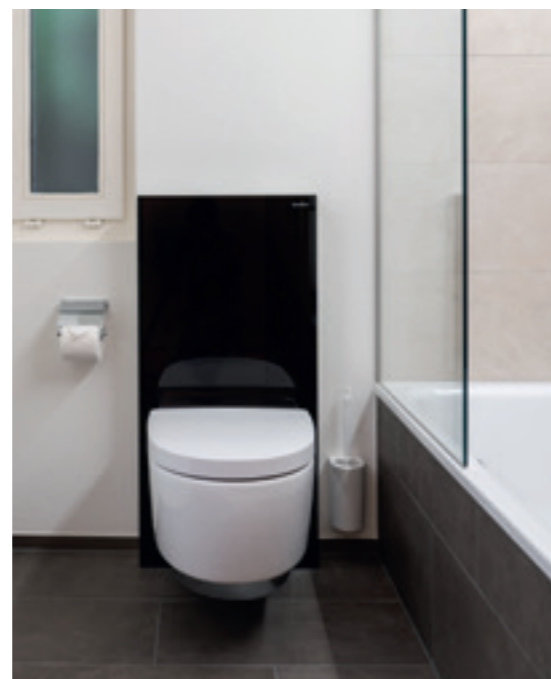
DOPO Situazione di installazione con Geberit Monolith.
